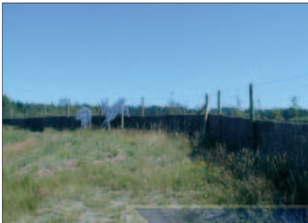
Foto 1: Francie – pohled na těleso migračního objektu, spodní část plotu v neprůhledném provedení pro omezení rušení migrující zvěře
