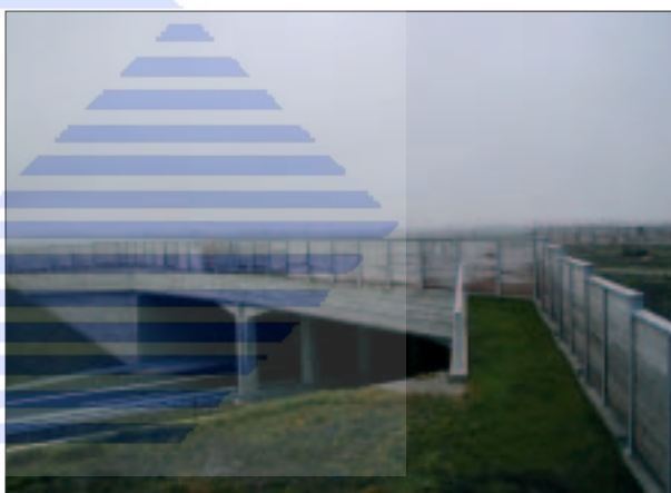
Foto 4: Berlín – vstup na migrační objekt s oplocením pro navedení migrujících živočichů
