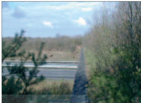
Foto 4: Berlín – vstup na migrační objekt s oplocením pro navedení migrujících živočichů
