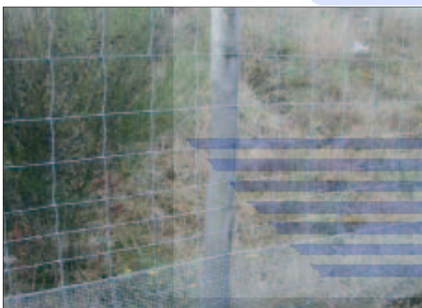
Foto 3: Brusel – oplocení ze dvou druhů pletiva zajišťuje funkčnost i pro drobné živočichy
