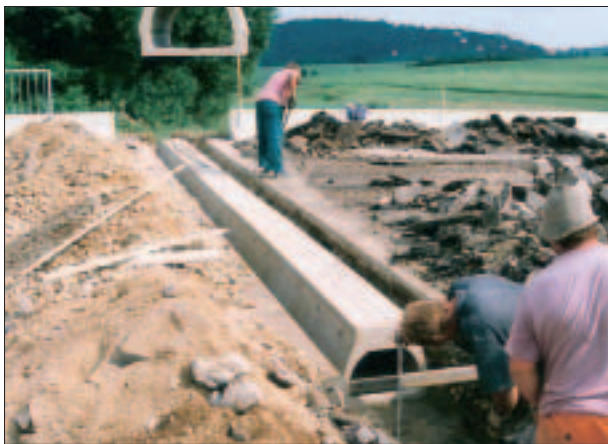
Foto 1: Ukázka stavby propustku – foto Pavel Šára, ACO Stavební prvky s.r.o.
