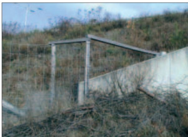
Foto 5: Brusel – větve podél naváděcí stěny do podchodu pro usnadnění migrace
